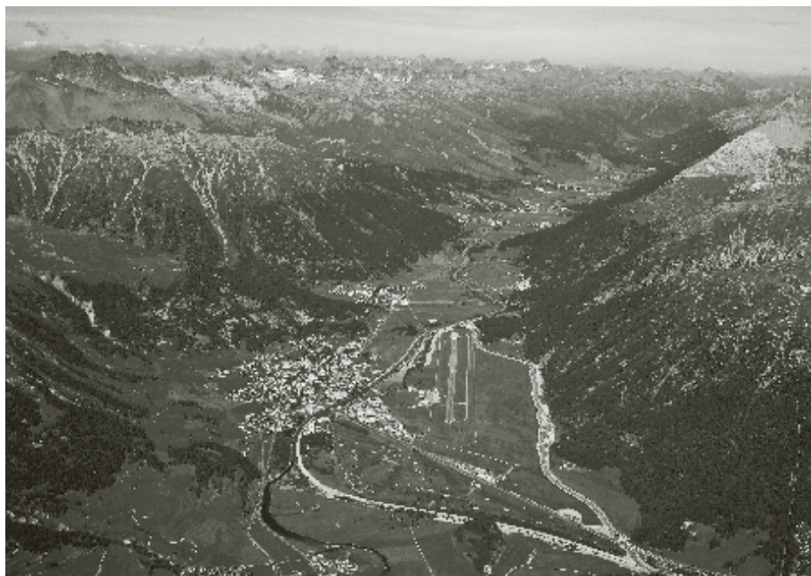
Le danger de crue est écarté : le nouveau lit du Flaz a été aménagé sur une longueur de 4 kilomètres du côté opposé de la vallée, par rapport à Samedan. Désormais, il se jette dans l'Inn seulement après l'aéroport et la commune. Avant son détournement, il se jetait encore dans le fleuve principal, en amont de Samedan.
